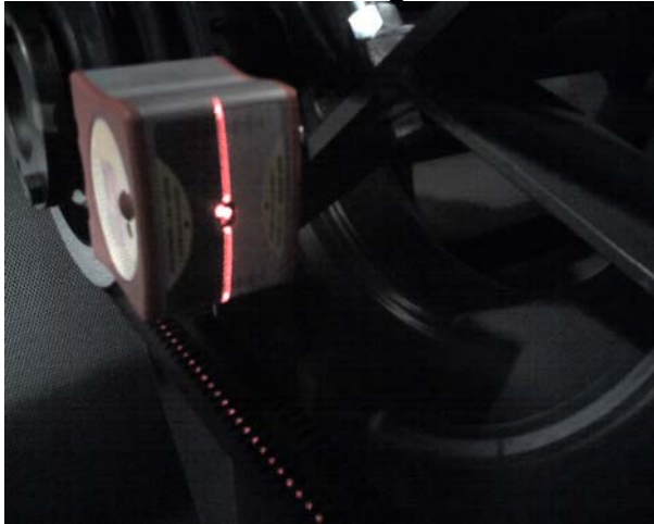
Fan Sheave Alignment
